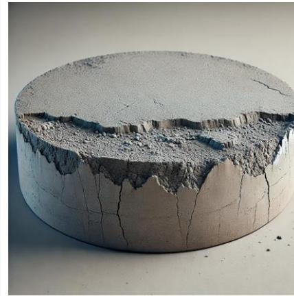
生コンクリートの特性上、地面に対して平行になる面、例えば、**土間コンクリート**上面や**犬走コンクリート**上面は脆弱になりやすい特徴があります。これらの箇所は、必ず水洗いによって脆弱な部分を除去してから、補強効果が期待できるシーラーを施工してください。
