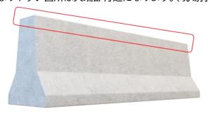
現場打ちされたコンクリートにおいて、打ち継ぎを行わず1発で打設・仕上げを行ったカベコンクリートの場合、上記図の赤枠で囲った「天端部及びその付近」はコンクリートが脆弱に仕上がりやすい箇所になります。劣化進行も早く進む可能性が高い為、この箇所は清掃・補修・補強・NURUCON施工は慎重に行ってください。
